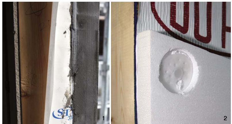
1 경량 목구조 주택에 별도 외단열을 시공한 모습. 2 외단열 미장 공법 및 스타코 공법용 Tyvek® Drain Wrap®으로 시공한 경량 목구조 주택.
