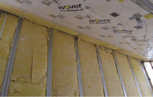
한국하니스(주) 'ISOVER' 고밀도 글라스 울로 벽체와 천장을 충전한 판교 패시브 하우스 시공 현장.
