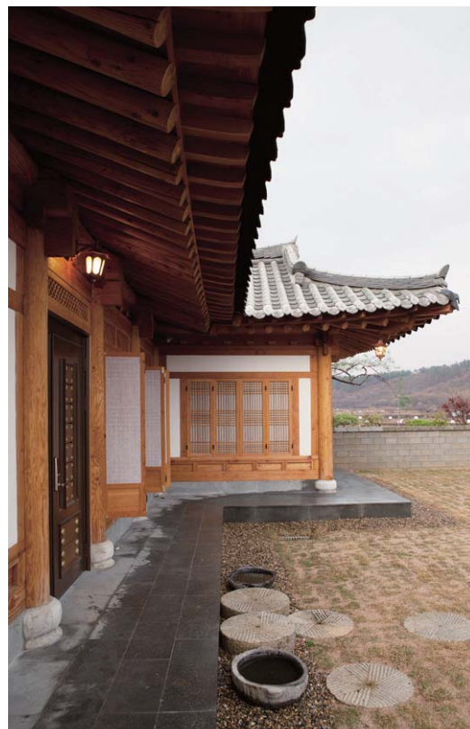
‘ㄱ’자형 단층 오랑 목구조 팔작지붕 아름자리 한옥(左). 빗물이 들어치지 않도록 처마를 길게 뻗고 지붕에서 빗물이 떨어지는 대리석 지대 앞에 흙이 패지 않게 잔돌을 깔았다(右).
