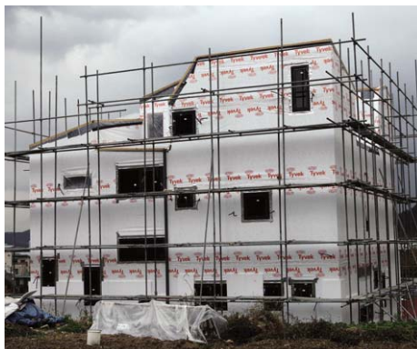
외피는 방수·방풍·방습용 하우스 랩으로, 창과 문틀은 기밀 테이프로 시공한 모습.
