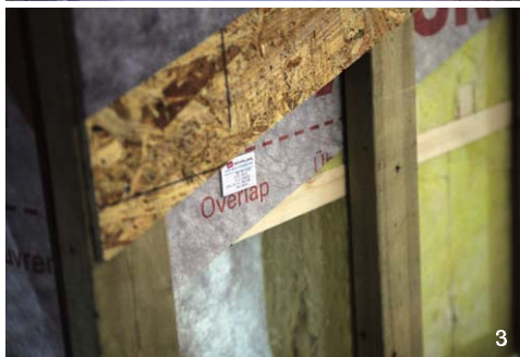
1 창호 프레임에 단열재로 감싸고 기밀 테이프로 마감했다. 2 고밀도 글라스 울로 시공한 워프 루프. 3 워프 루프 구조.
