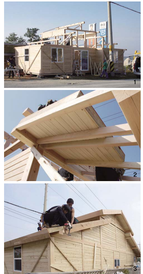
1 서까래를 올리기 전, 골조가 완성된 모습. 2 지붕재 단면. 3 처마 시공.
