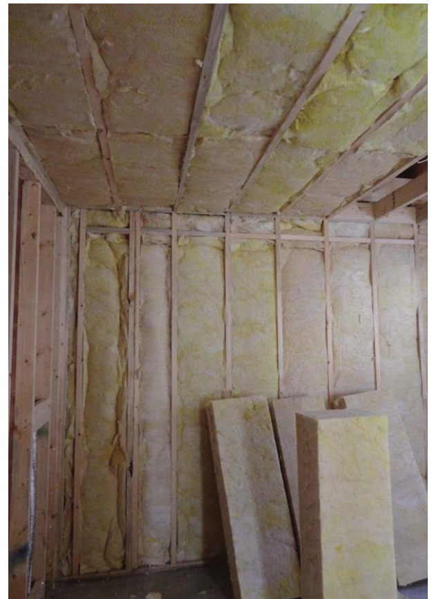
고밀도 글라스 울 단열재로 시공 중인 경량 목구조.
